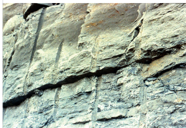
Ouverture de joints stratigraphiques à la suite d'un tir ménagé devant un tir de prédécoupage dans des grès (bancs d'épaisseur métrique), mine de charbon de Decazeville. (Photographie : R. Cojean)
