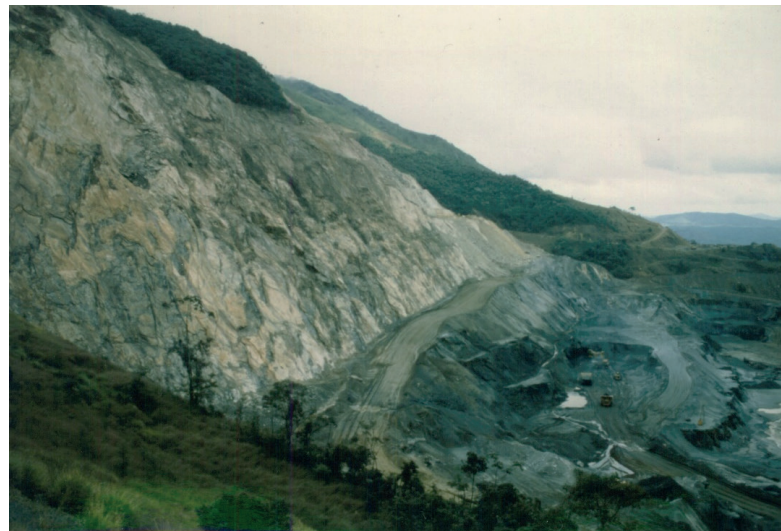
Figure 32 : Vue d'ensemble du flanc sud de la mine de Timbopéba (Photographie R. Cojean)
