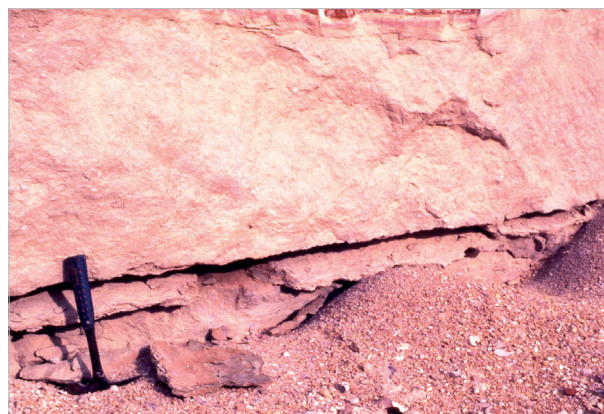
Ouverture de joints stratigraphiques argileux d'épaisseur millimétrique à la suite de tirs de fragmentation en masse, mine de phosphate de ben Guérir, OCP, Maroc. (Photographie : J.-A. Fleurisson)
