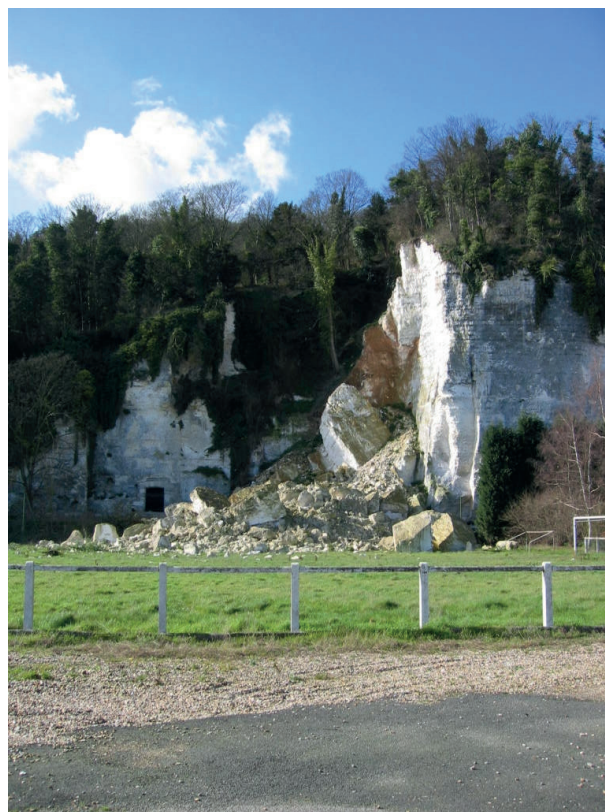
Figure 11 : Basculement d'une colonne de craie aux environs de Rouen (Photographie J.L. Durville)
