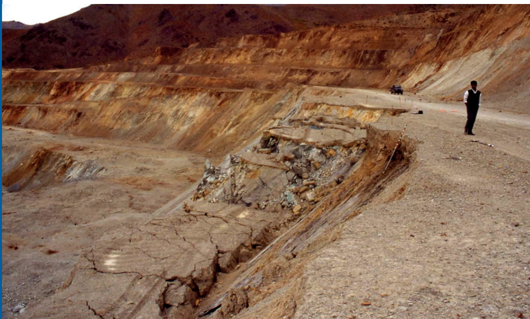
Figure 31 : Rupture en dièdres emboîtés prenant appui sur la famille de faille du Zagros et rendus possibles par la contribution de la matrice rocheuse à la rupture (Photographie R. Cojean)
