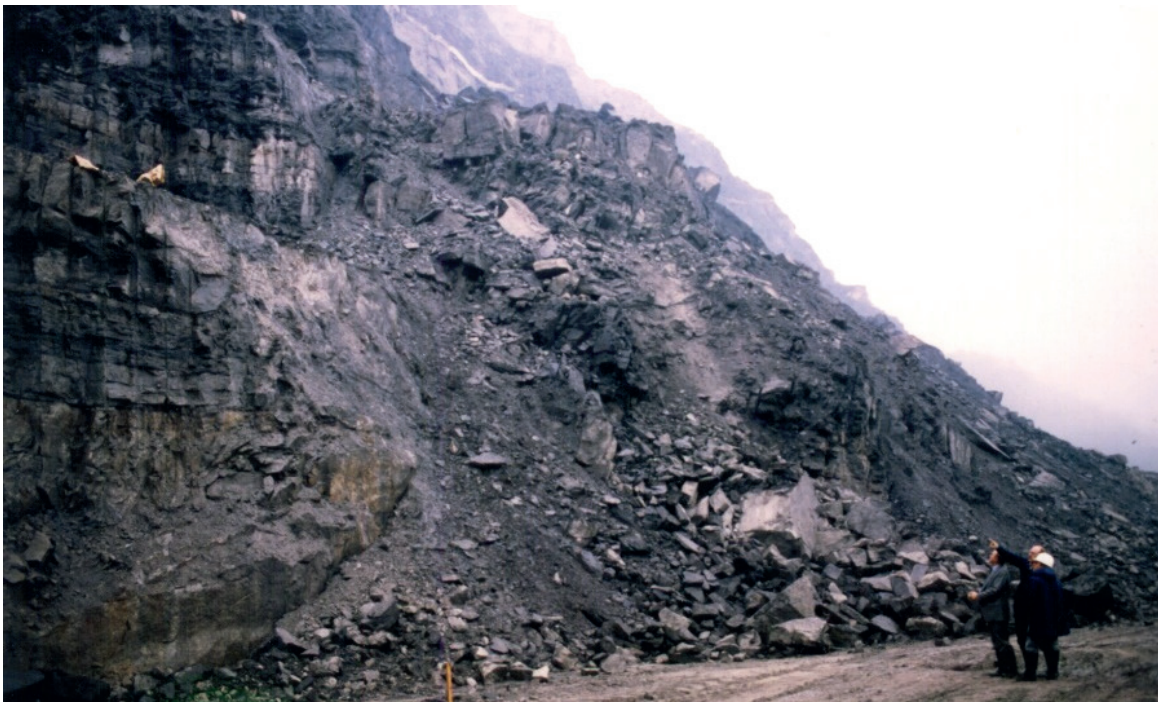
Figure 27 : Vue du glissement affectant une partie du flanc ouest de la Découverte de Decazeville (Photographie R. Cojean)
