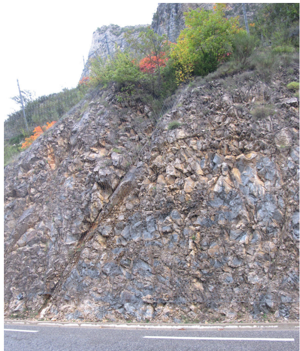
Figure 1 : Illustration du fait que l'on peut rencontrer une discontinuité bien exprimée et persistante, mais quasi-unique et isolée dans un massif rocheux très fracturé (calcaire éocène près d'Annot (04) (Photographie J.L. Durville)
