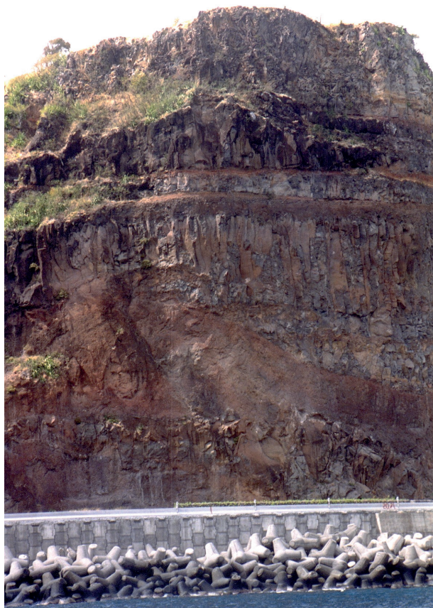
Figure 19: Falaise dominant la RN 1 à La Réunion : superposition de coulées épaisses, quasi-horizontales, traversées par des fractures subverticales nombreuses, et de lits de projections volcaniques érodables (Photographie J.L. Durville)
