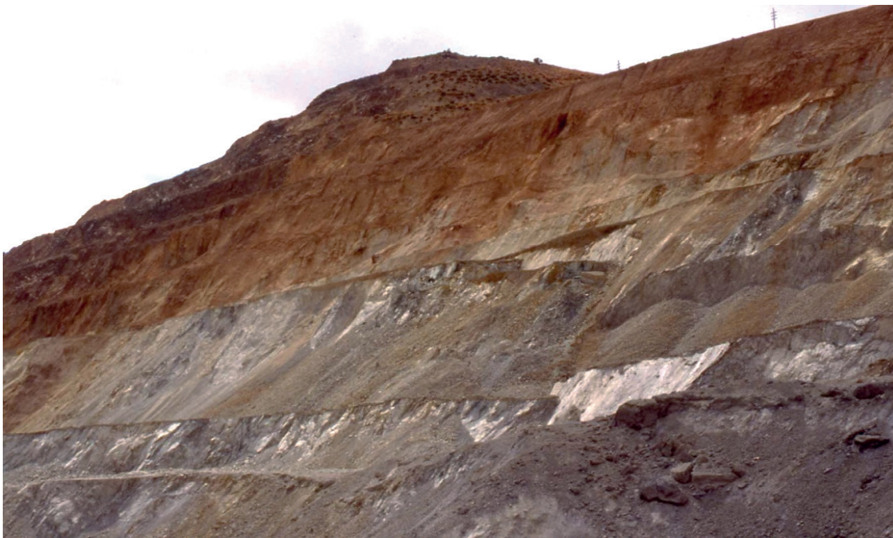
Figure 29 : Flanc SW de la mine de Sar Cheshmeh ; les surfaces brillantes correspondent à des plans de faille (miroirs de faille, système du Zagros) rentrant obliquement dans le talus (Photographie R. Cojean)
