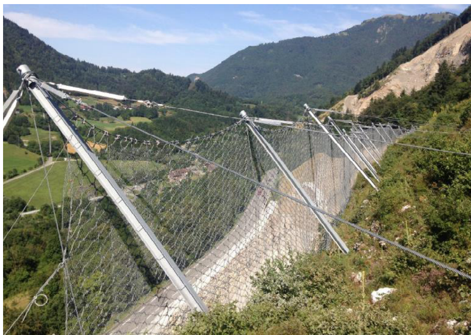
Figure 14 : Avaloir dérivé d'un écran ETAG (Source : NGE)
