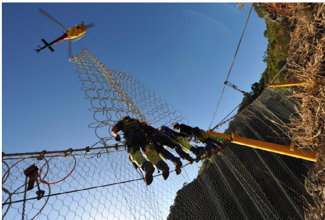
Figure 23 : Hélioportage d'un filet d'avaloir (Source : NGE)
