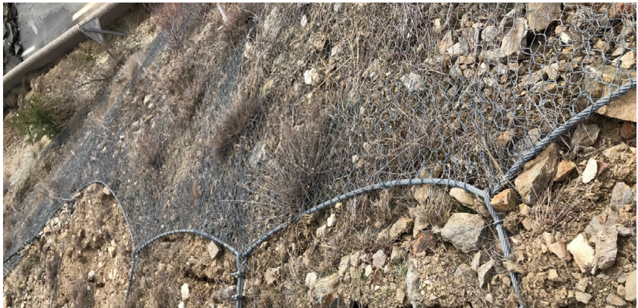
Figure 10 : Une rive supérieure sous tension : pas de résistance possible sans flèche (Source : NGE)
