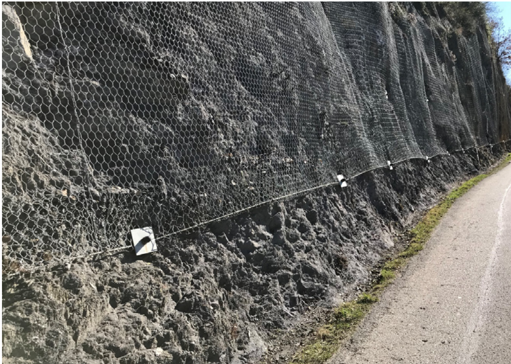
Figure 18 : Exemple de ligne de placage inférieur (Source : NGE)
