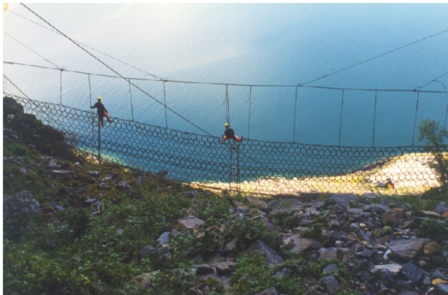
Figure 12 : Exemple de système de suspension (Source : AVAROC)
