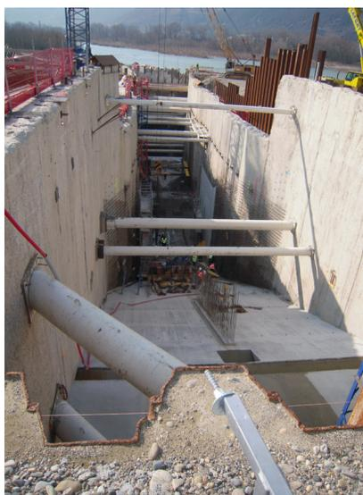
Figure 2 : Deux parois moulées butonnées de la micro-centrale électrique de Rochemaure (Ardèche ; 2015) - Photo © Compagnie Nationale du Rhône
