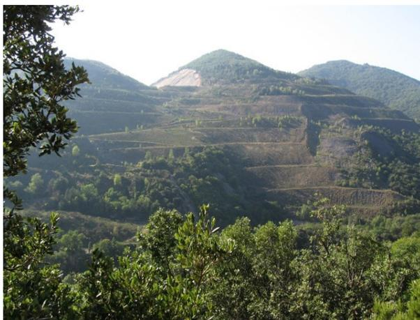
*Figure 2 : Mine de charbon dans le sud de la France. Cinq ans après les travaux de stabilisation, gestion des eaux, et végétalisation*
