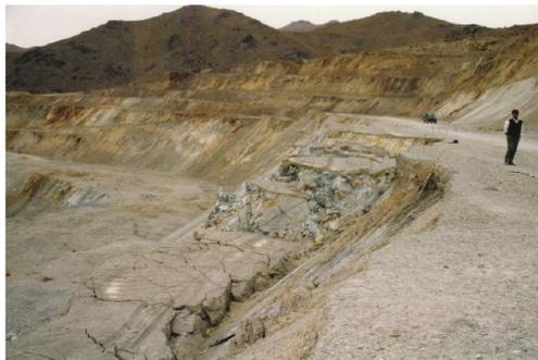
*Figure 6 : Flanc sud-ouest de la mine de cuivre de Sar Cheshmeh en Iran. Vue générale et mécanisme de rupture par dièdre, (photo R. Cojean, 2001)*
