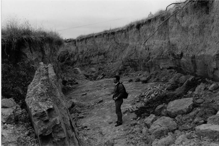
*Figure 1 : Glissement sur un inter-banc argileux lors de l'ouverture d'un déblai à Villedieu-les-Poëles (Manche). Le pendage est de 14°. Cliché J-L. Durville*
