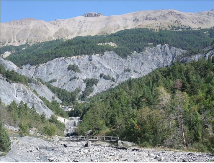
*Figure 3 : Le torrent du Riou-Bourdoux : vue sur quelques uns des seuils régularisant l'écoulement torrentiel ; formes d'érosion dans les marnes du Callovo-Oxfordien ; pentes boisées. Les crêtes sont découpées dans les flyschs des nappes de l'Embrunais (photo R. Cojean, 2010).*
