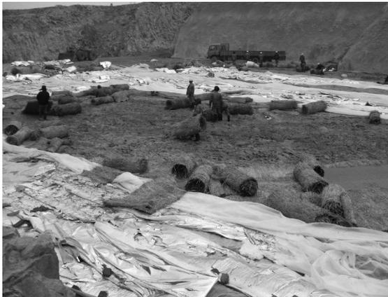
Figure 9 : Protection des fonds de fouilles de Hong Yan He contre la gélifraction
