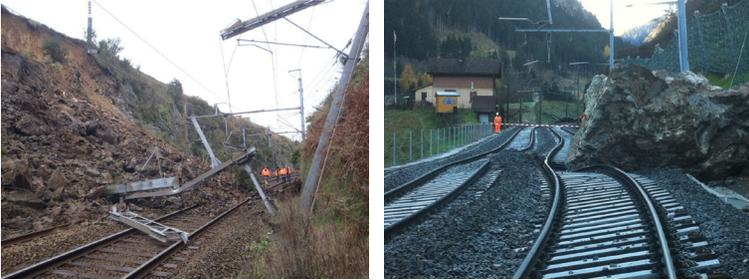
Figure 5 : Exemples d'incidents sur les voies ferrées - (à gauche) Éboulement d'un déblai rocheux à la sortie de la gare de Morlaix, dans le Finistère, en 2013 (1500 m<sup>3</sup>) ; (à droite) Un bloc de 80 m<sup>3</sup> termine sa chute sur les voies à Gurnellen, Suisse, en 2012.
