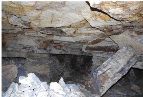
Figure 4 : Toit de la carrière souterraine affecté par des chutes de blocs (source : INERIS)
