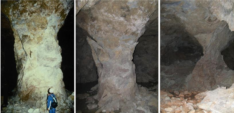
Figure 3 : Étapes de dégradation d'un pilier (source : INERIS)
