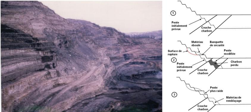
Figure 4 : Flanc ouest de la mine de charbon de Decazeville : vue générale et instabilité de pente (à gauche) et gestion des travaux d'excavation (à droite), (Cojean, 2001)
