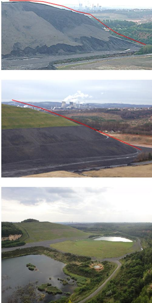
Figure 4 : Exemple de stabilisation par talutage d'un terril de charbon en Lorraine
