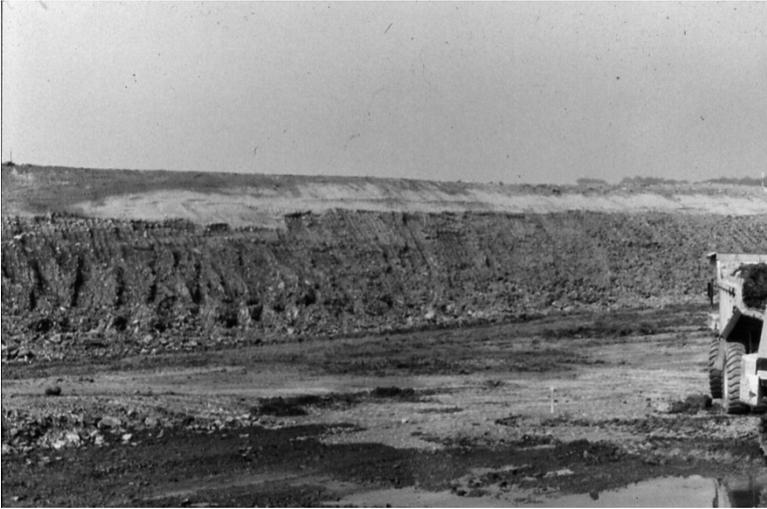
Figure 2 : Coupe naturelle d'un talus, au niveau des fouilles de la centrale de Cattenom, montrant la séquence d'altération des marnes du Domérien
