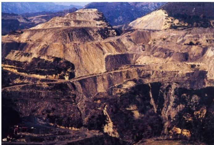
*Figure 1 : Cas d'une mine de charbon à ciel ouvert dans le sud de la France en 1990, avant réaménagement - Les stériles ont été déversés dans les coteaux, sur de fortes pentes, sans précautions particulières. Les terrains présentent une forte érosion, et sont instables.*
