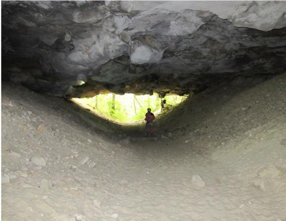
*Figure 1 : Ancienne carrière dans les sables de Fontainebleau : le toit est constitué d'un banc grésifié épais (photo J-L Durville)*
