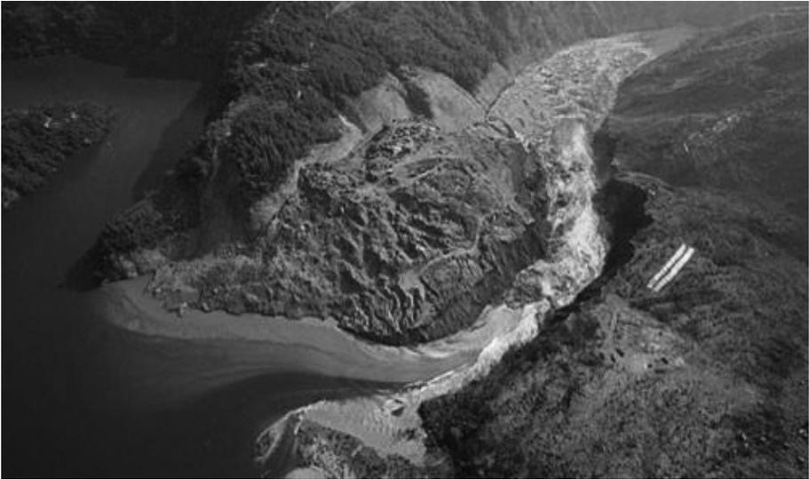
*Glissement et barrage de Tangjiashan, sur la rivière Jian, en amont de la ville de Beichuan (Sichuan, Chine). Déversement par surverse, après creusement d'un chenal (Photo © R.Q. Huang)*
