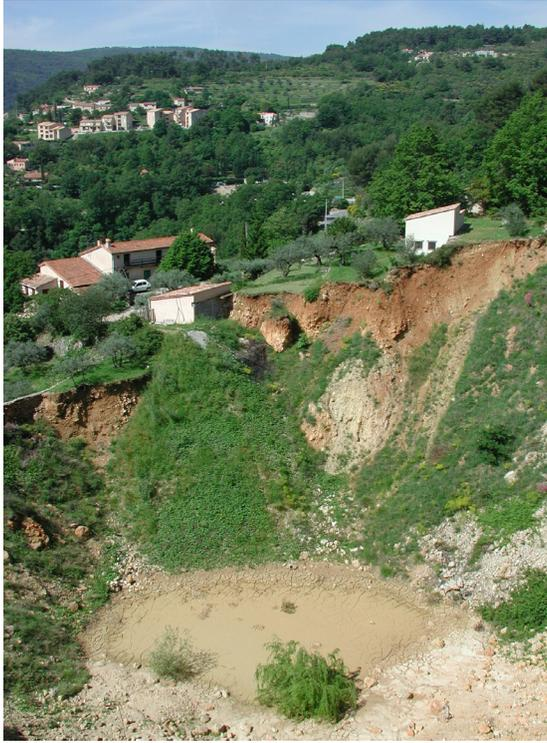
Figure 8 : Effondrement à Bargemon (Var) en 2001 (photo J-M Le Cléac'h)
