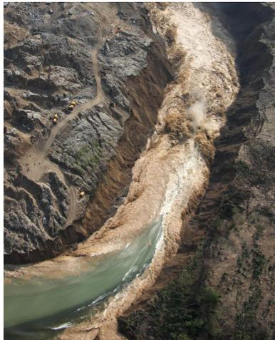
Figure 6 : 10 juin 2008. Surverse et érosion violente sur le barrage de Tangjiashan (Photo transmise par Huang R.Q.)
