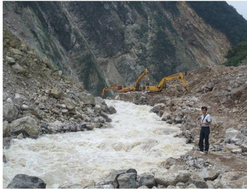
*Figure 7 : Travaux d'approfondissement du chenal d'évacuation des eaux du barrage. À gauche : masses glissées du glissement de Xiagangjian (en rive droite) ; à droite : dépôts de coulées de débris (en rive gauche) (Photo R. Cojean).*
