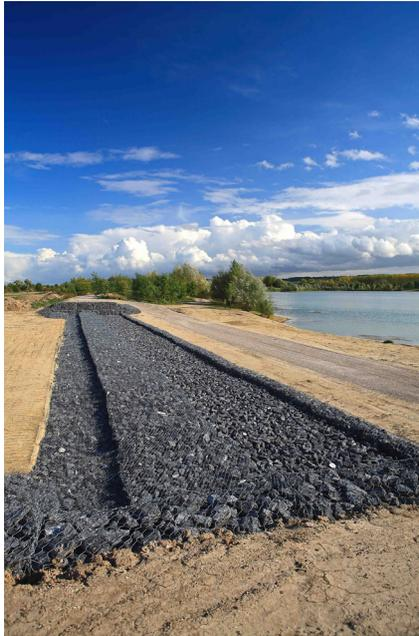
Figure 6 : Vue du seuil fixe servant à alimenter en phase de crue l'un des casiers (Photo P. Laugier)
