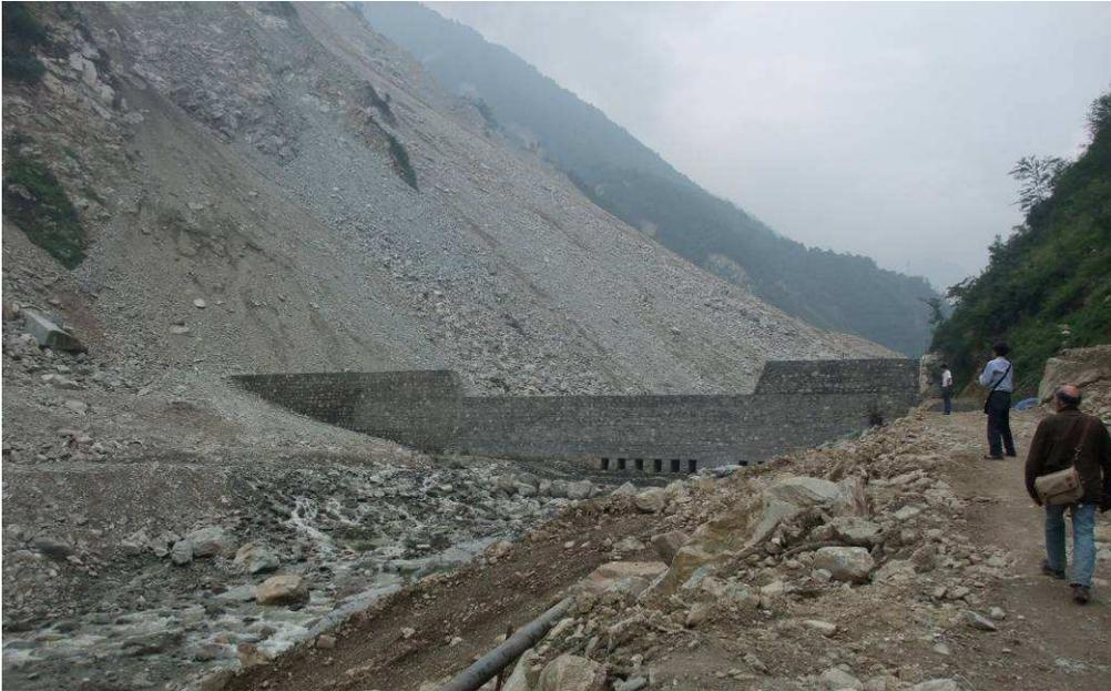
*Figure 98 : Versants déstabilisés par des glissements rocheux et des éboulements. Travaux de correction torrentielle par check dams*
