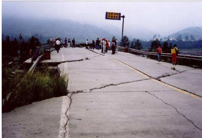
Figure 34 : Pont de Xiao Yu Dong : remblai d'accès en rive droite, traversé par une faille secondaire
