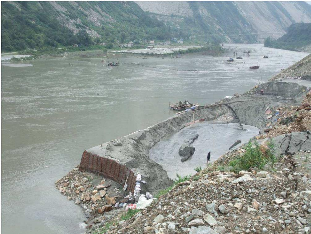
*Figure 97 : Lac de barrage avec travaux de dragage destinés à récupérer du sable qui s'accumule dans la retenue*
