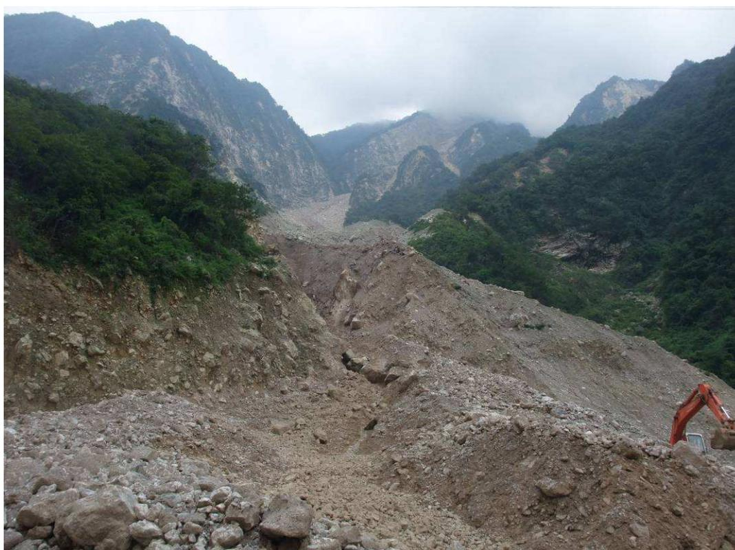
*Figure 80 : Accumulation de produits de debris flows (lave torrentielle) en rive gauche de la rivière Mianyuan, face au glissement de Xiagangjian. Travaux de rétablissement d'une piste en cours*
