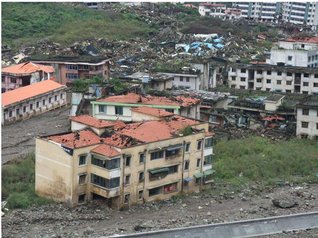
*Figure 52 : Vue du bourrelet de débris au front du glissement de Wangjiayan. Au premier plan, immeuble en partie enfoui par les coulées de débris*
