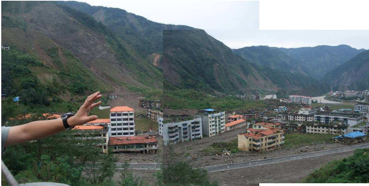
*Figure 51 : Vue du glissement de Wangjiayan. Au premier plan, bâtiments très endommagés par le séisme, puis enfouis sous 5 à 7 m de dépôts de coulées de débris déclenchées plusieurs mois après le séisme par des pluies intenses*
