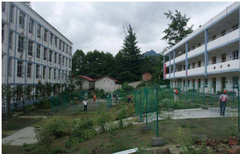
Figure 41 : La cour de l'école de Bailu, déformée par le jeu de la faille (faille inverse de rejet vertical de 3 m environ). Elle était initialement horizontale. Le bâtiment de gauche, plus ancien que celui de droite, est plus endommagé mais ne s'est pas écroulé.
