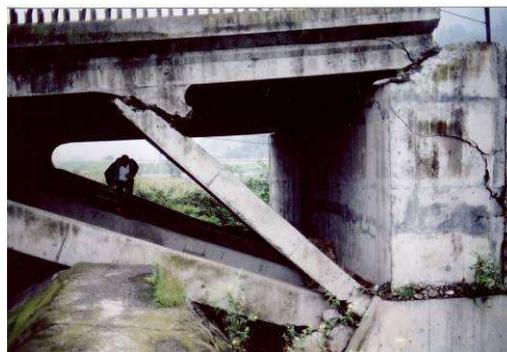
Figure 36 : Pont de Xiao Yu Dong : rupture de l'arc et du tablier au contact de la culée
