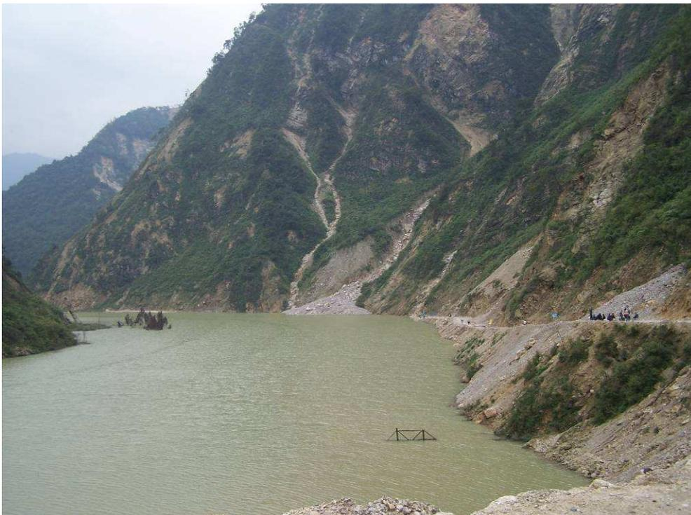
*Figure 82 : Lac de barrage de Xiaogangjian. Vue vers l'amont (un pylône de l'ancienne route émerge). La piste provisoire, visible sur la droite, a été envoyée suite à la formation du debris flow et la remontée du niveau du lac*
