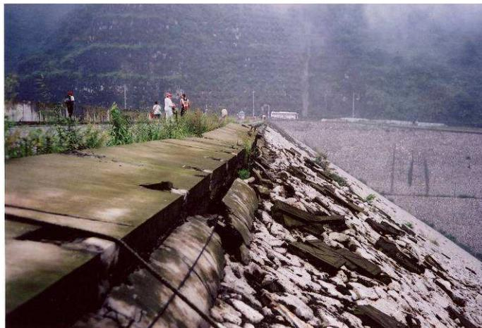
Figure 38 : Parement aval du barrage de Zipingpu. On observe le tassement de la crête et les désordres affectant le perré.
