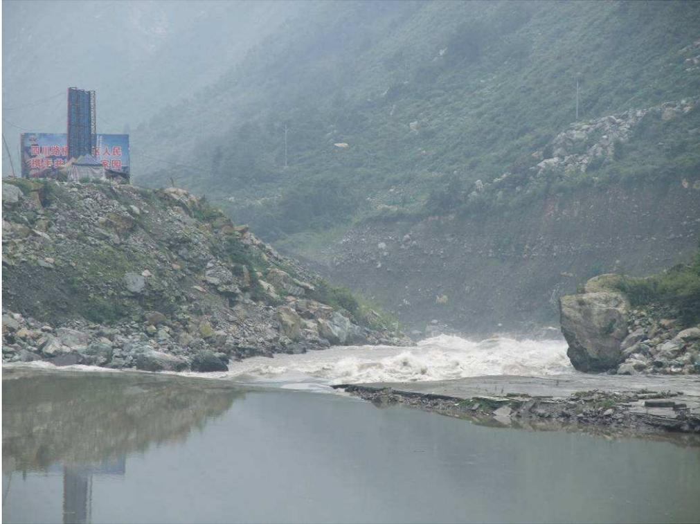
Figure 86 : Vue vers l'aval du seuil en cours d'érosion. Noter la rive droite fortement érodée lors du phénomène de surverse
