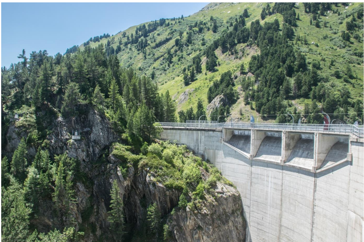
Figure 11 – Vue d'un des barrages (ici la voûte) fermant la retenue de Plan d'Aval. A noter les deux cibles fixes de mesure sur l'éperon rocheux (côté gauche de la photo), permettant le suivi des déformations de l'ouvrage.
