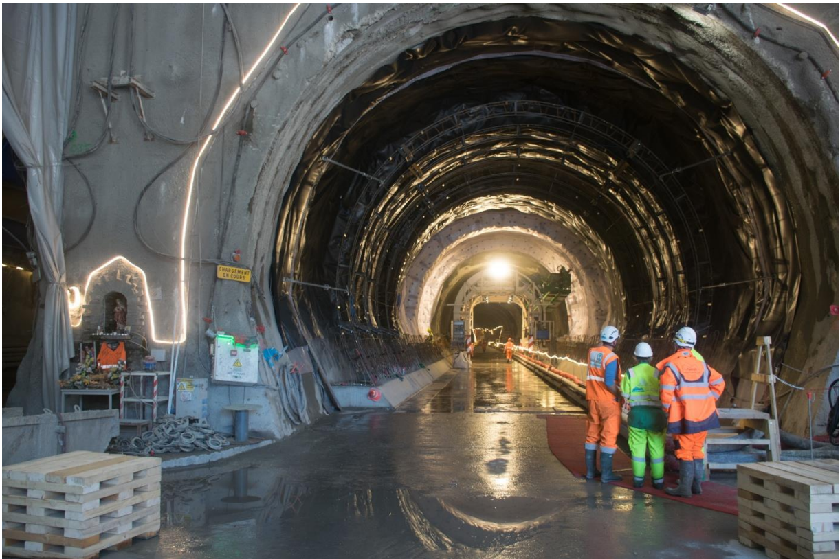
Figure 4 – Entrée du tube sud côté Saint-Jean-de-Maurienne du tunnel de base Lyon-Turin, réservé aux trains circulant vers la France. Les sections divergentes (succession de tronçons de cône) sont caractéristiques d'un avancement à l'abri de voûtes-parapluie. L'étanchéité a été posée, le radier bétonné, les armatures du revêtement définitif positionnées.
