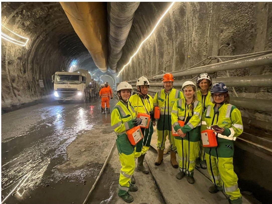
Figure 5 – Demi-groupe dans le tube sud du tunnel de base du Lyon-Turin (Chantier Opérationnel 08 de TELT).
