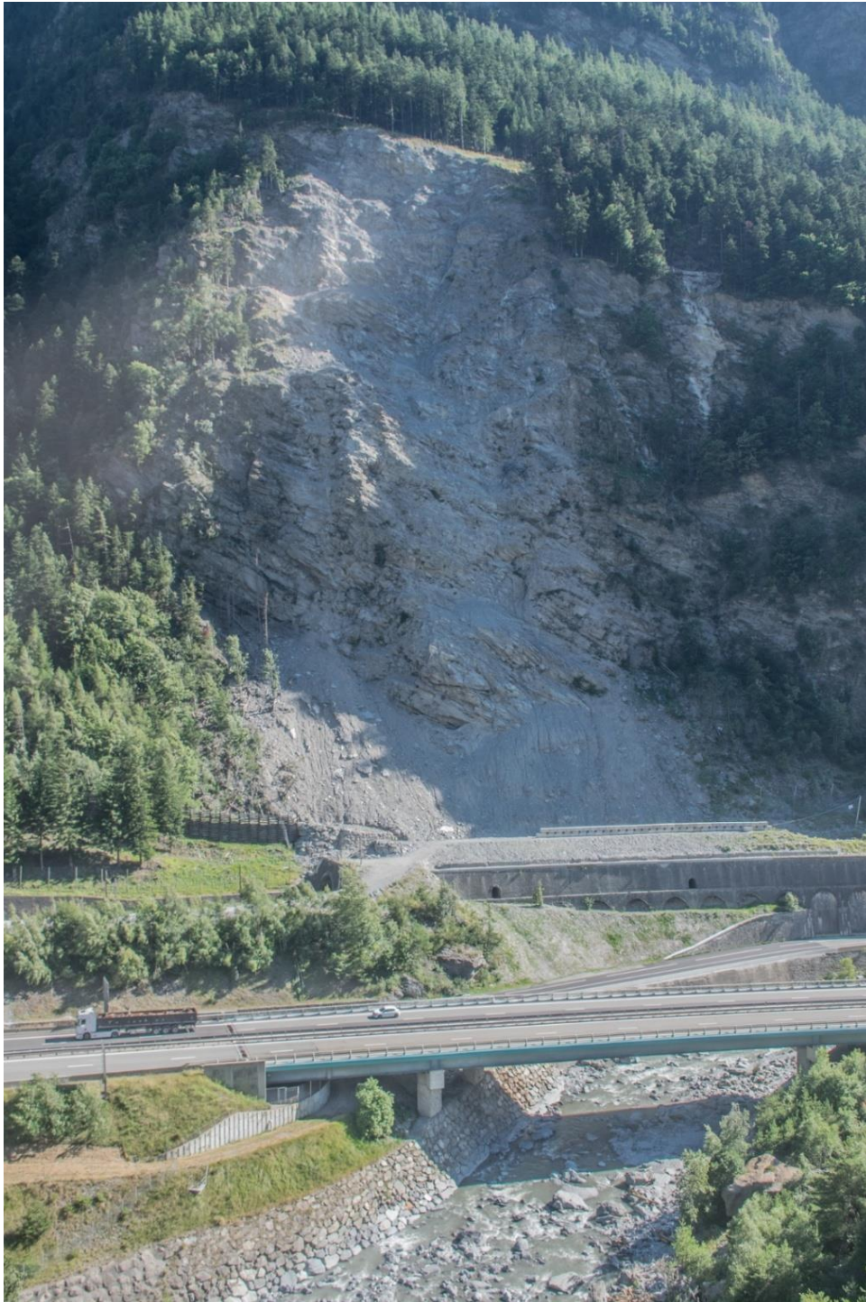
Figure 10 – Le site de la Praz : la paroi objet de l'effondrement de 2023, le tunnel ferroviaire de la Brèche, la route départementale 1006 et l'autoroute A43.
