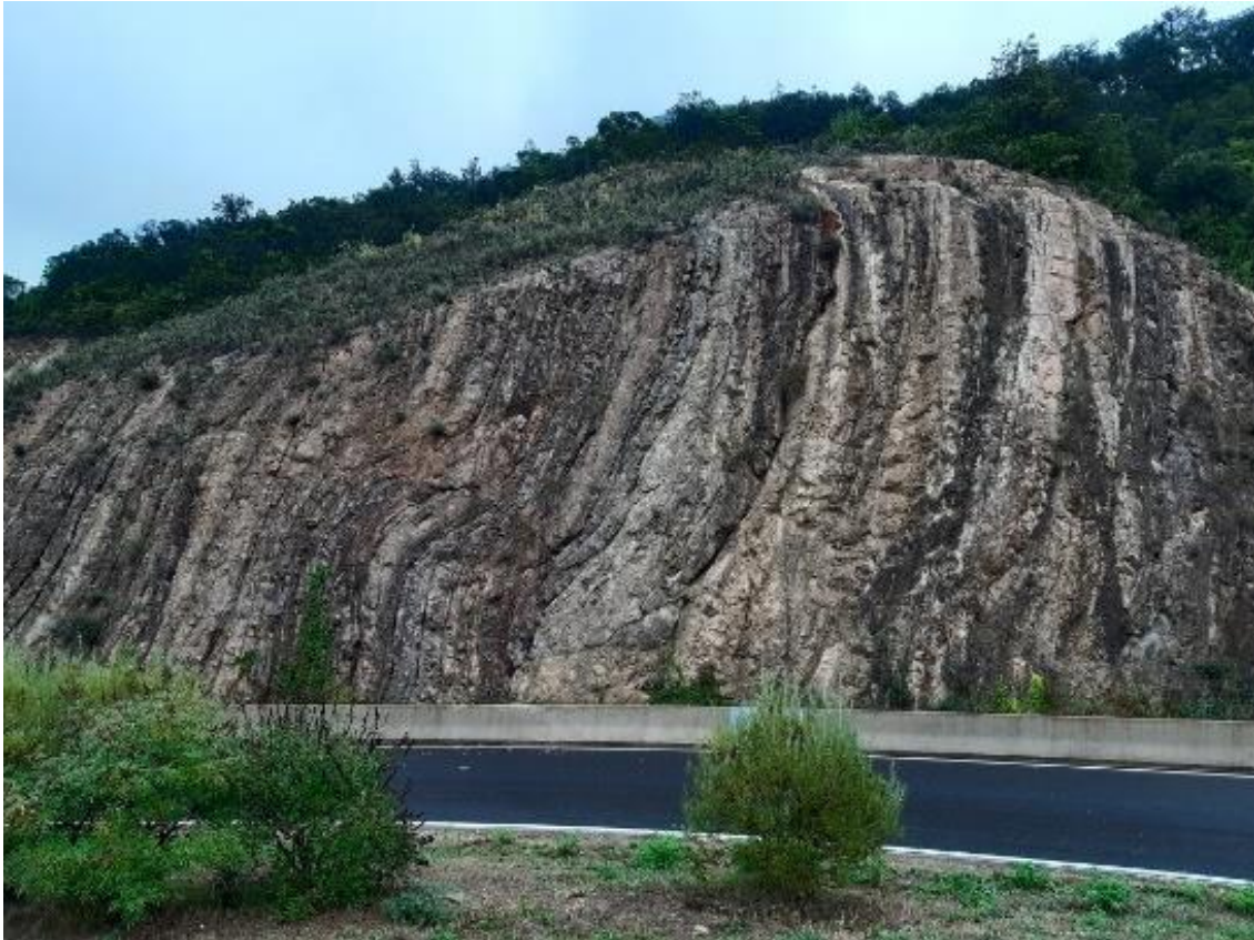
Figure 4 : de l'importance du modèle géologique dans le design des talus rocheux : déviation de Bédarieux au niveau du chevauchement de la Montagne Noire
