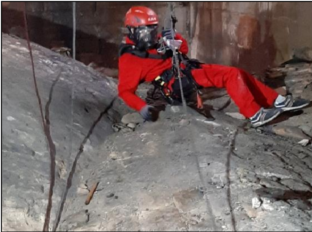
Notre-Dame de Paris, intervention au-dessus d'un voûtain, 2020. © LRMH
